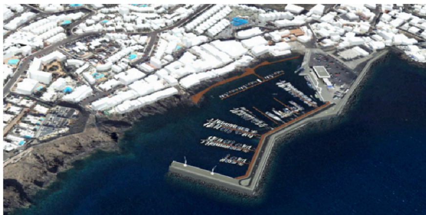
Ampliación del Puerto de Puerto del Carmen
